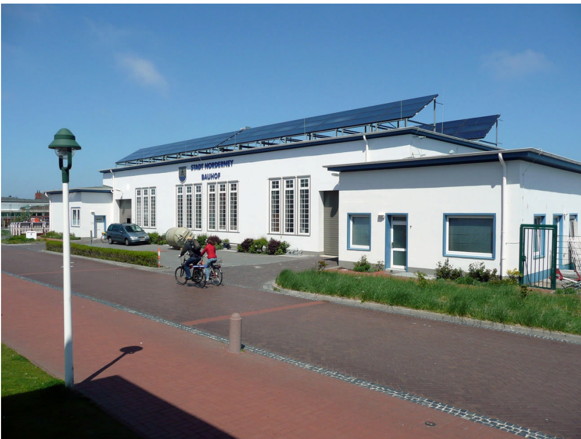
Abbildung 4: Ansicht Bauhof Wirtschaftsbetriebe Norderney
