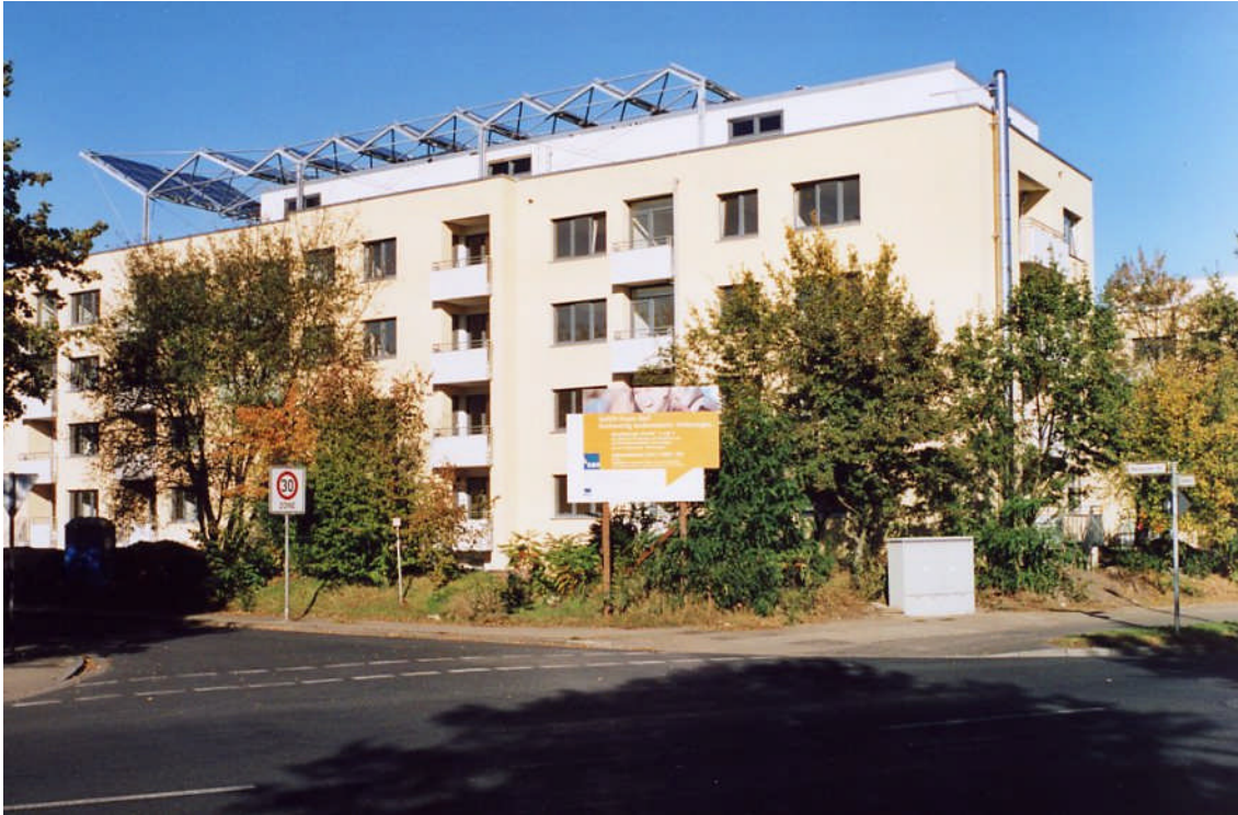
Abbildung 2: Ansicht Gebäude Magdeburger Str. 2 von der Durchgangsstraße
