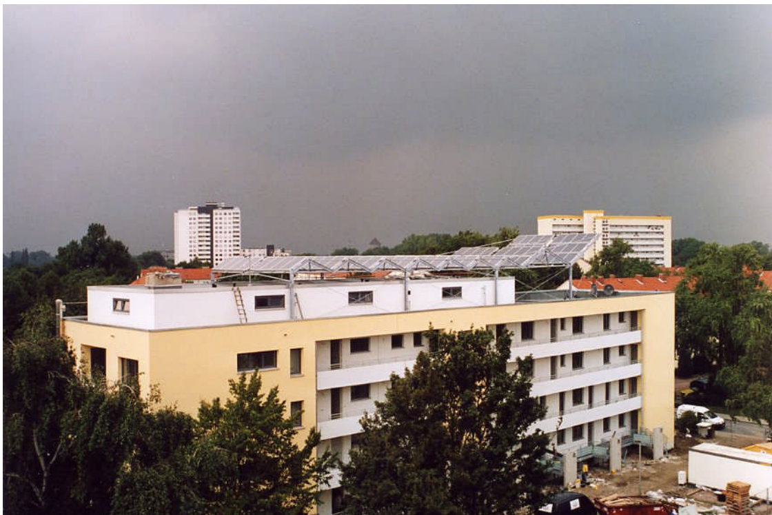
Abbildung 1: Ansicht Gebäude Magdeburger Str. 2 vom Nachbargebäude Magdeburger Str. 4
