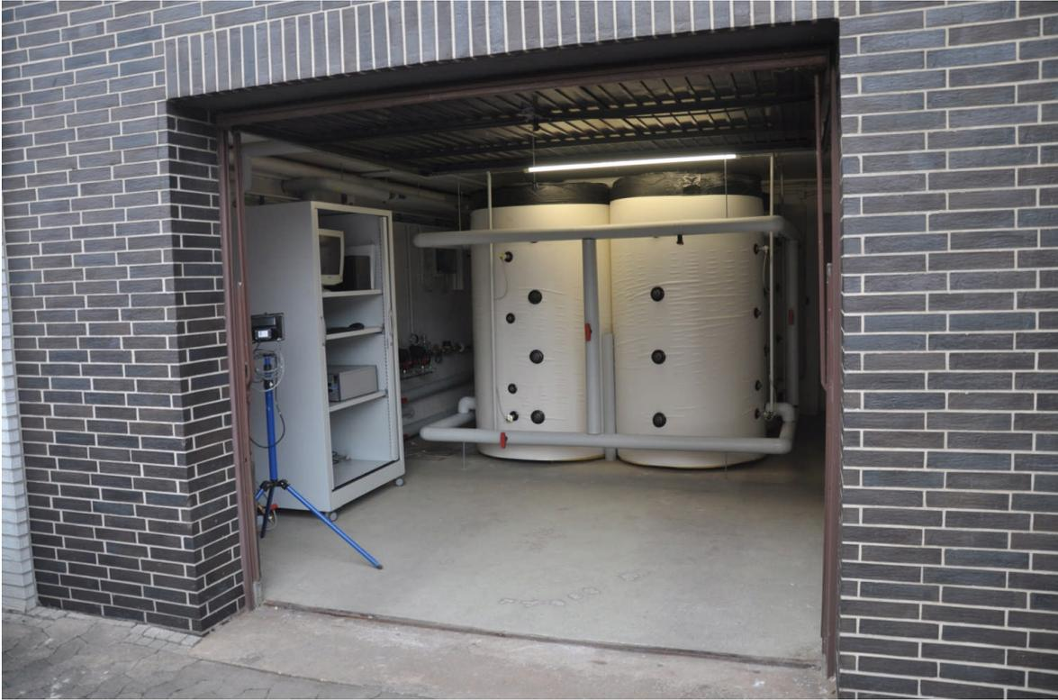
Abbildung 4: Aufstellraum der Solarpufferspeicher 4 x 1.500 l in einer ehemaligen Garage, links der Datenlogger in einem Schaltschrank
