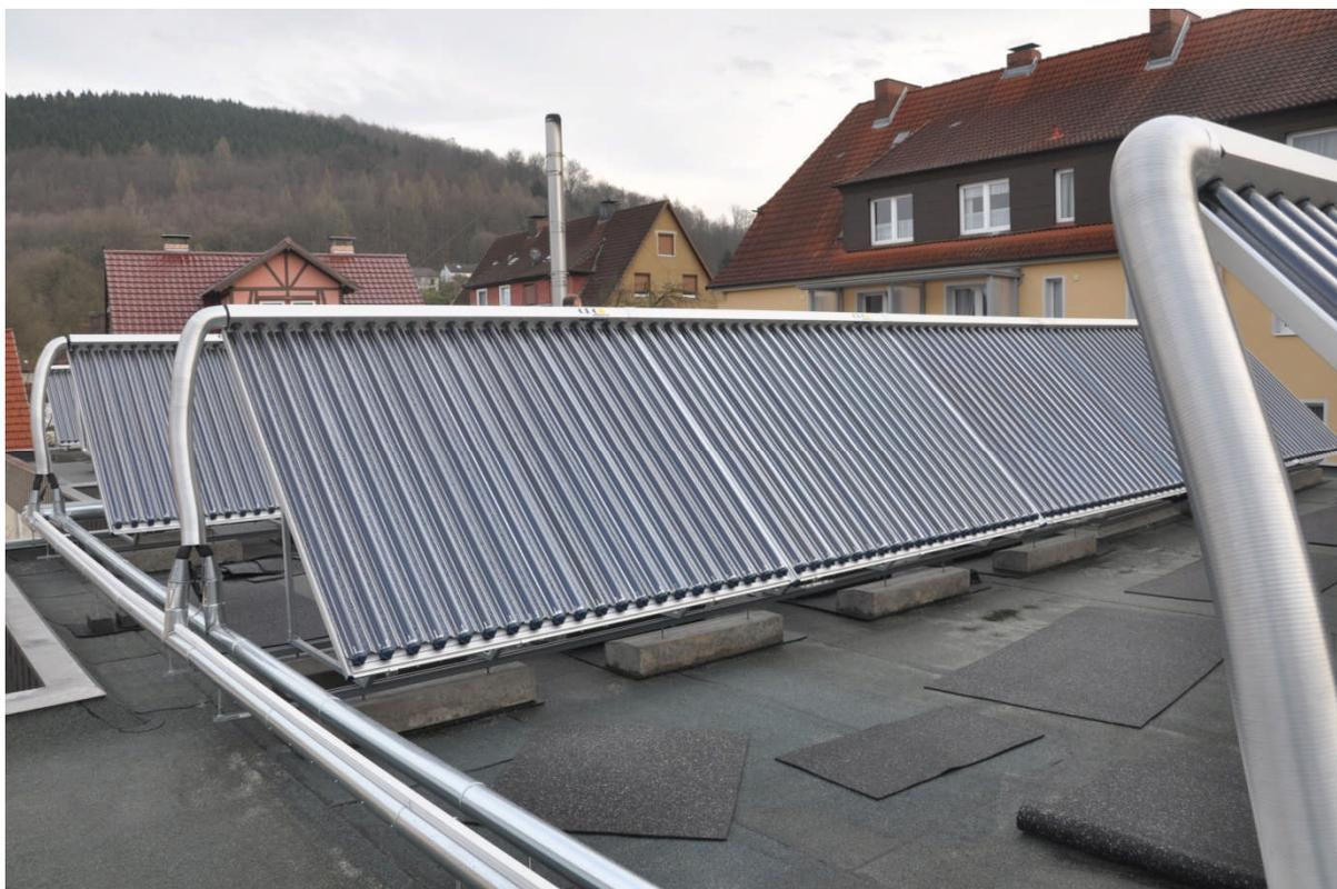
Abbildung 7: Teilansicht des Kollektorfeldes, der Montagerahmen ist auf Bordsteinen montiert
